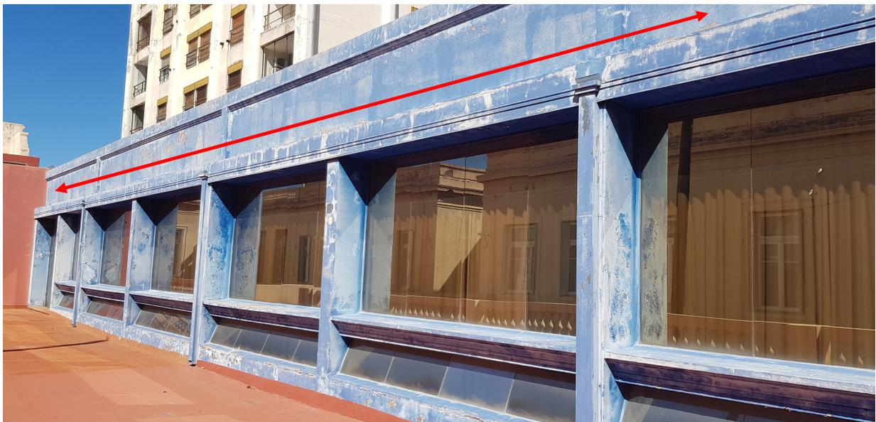
Los mismos se realizarán en zinguería con diseño para no romper con la línea de fachada, esto impedirá que el agua ingrese hacia el interior de área en caso de colapso de las canaletas. Habiendo dado solución a los problemas de filtraciones el oferente procederá a realizar las reparaciones internas de cielorraso y paramentos verticales.
