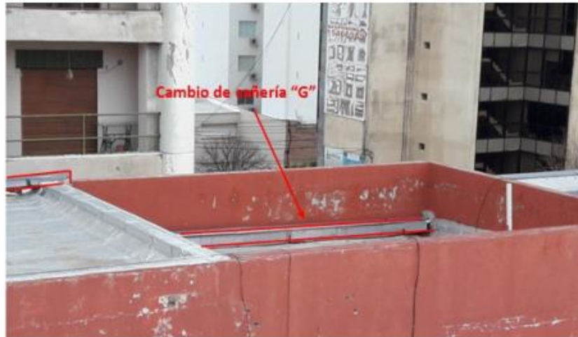
Ramal G – Techo sala de acuerdo y parte de la oficina del Dr. Levingston.
