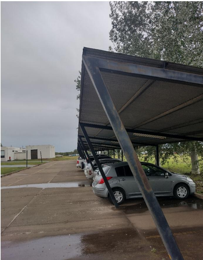
En el caso de la sección B: las estructuras, se realizarán, con perfiles C metálico de 140 mm x 60 x 3.2. Preferentemente armados tipo cajón, enfrentados y unidos por soldadura, cuya distancia se determinará, según los cálculos estructurales efectuados por el oferente y aprobados por la inspección de la obra.
